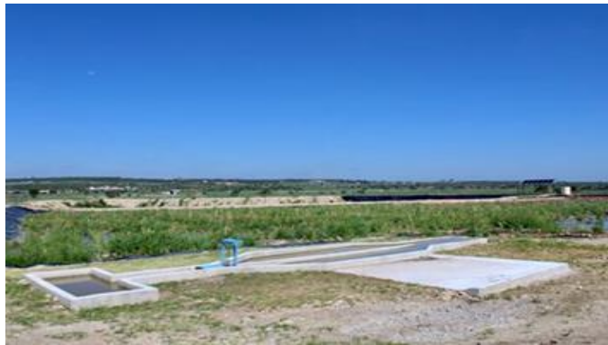
Sistema de tratamiento HC2 en SDA
