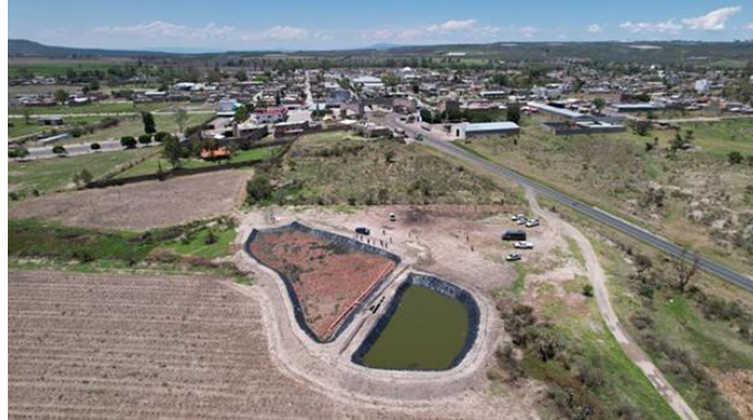
Sistema de tratamiento HC1 en SDA
